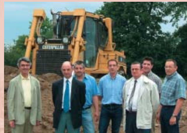
Début des travaux en présence de Jean-Louis GABY (Président de la Communauté de Communes), Serge LEFORT (Directeur de l'usine), Jean-Paul GRIGNON (Directeur industriel) et Jacques BERTHOMIER (Directeur de la Communauté de Communes)
